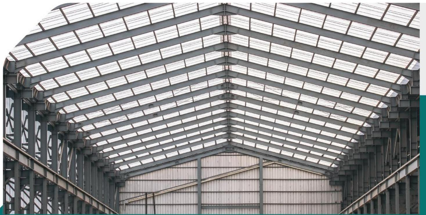
Atap fiberglass tembus cahaya berkualitas tinggi yang dilengkapi dengan lapisan UV yang melindungi dari bahaya sinar ultraviolet dan tahan terhadap perubahan cuaca untuk jangka waktu yang lama.
